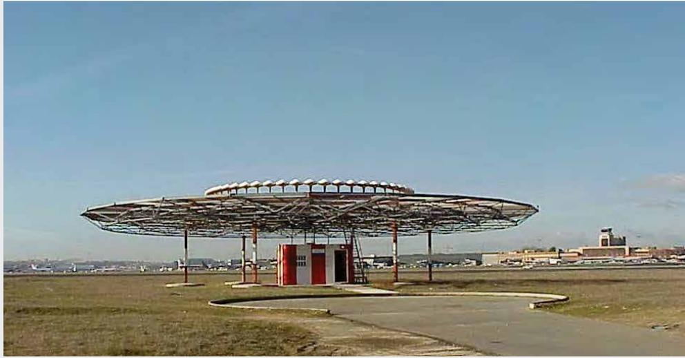
El sistema radiante del DVOR está constituido por una antena central o de PBL y un conjunto de antenas dispuestas en anillo de forma simétrica o antenas de BL (el número oscila entre 36 y 50 según fabricante). El radio del anillo es aproximadamente de 7 metros.
